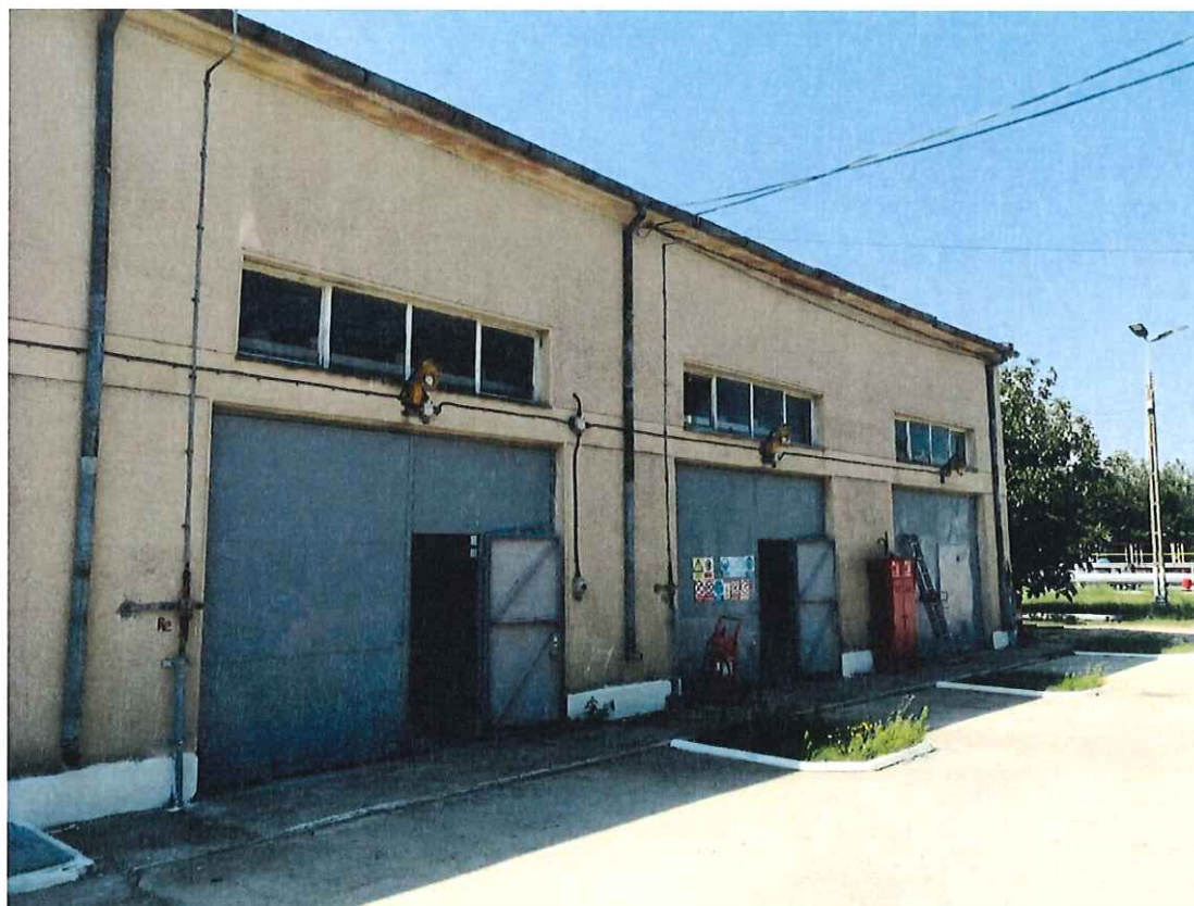
VEDERE NORD - EST A CLADIRII
