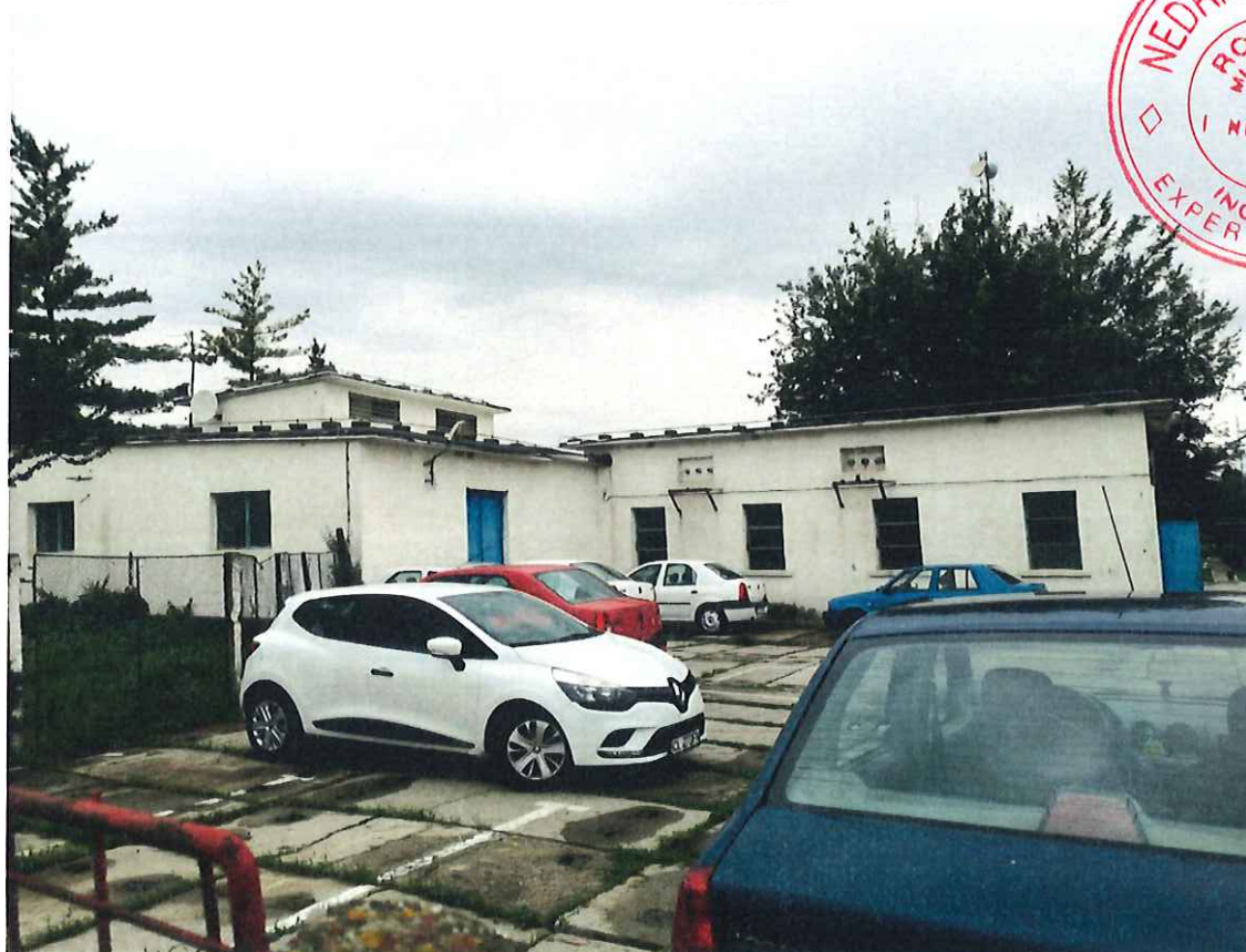
VEDERE EXTERIOARA CLADIRE - CORP DISTRIBUTOR D + ANEXA DEPOZITARE
