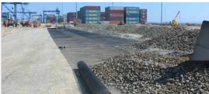
Geogrilăle Tensar sunt perfecte pentru fundatiile docurilor (Constanta)
