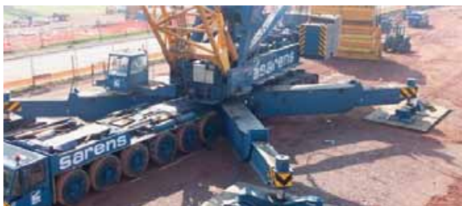
Macara de mare tonaj pe platforma de lucru stabilizata cu Tensar
