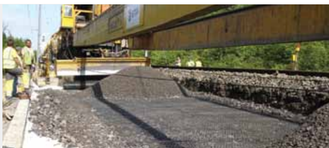
Beneficii ale stabilizării terenului cu Tensar la calea ferata
