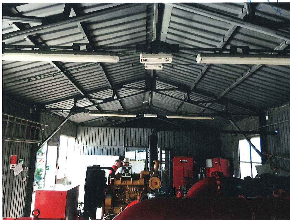
VEDERE INTERIOARA CLADIRE
