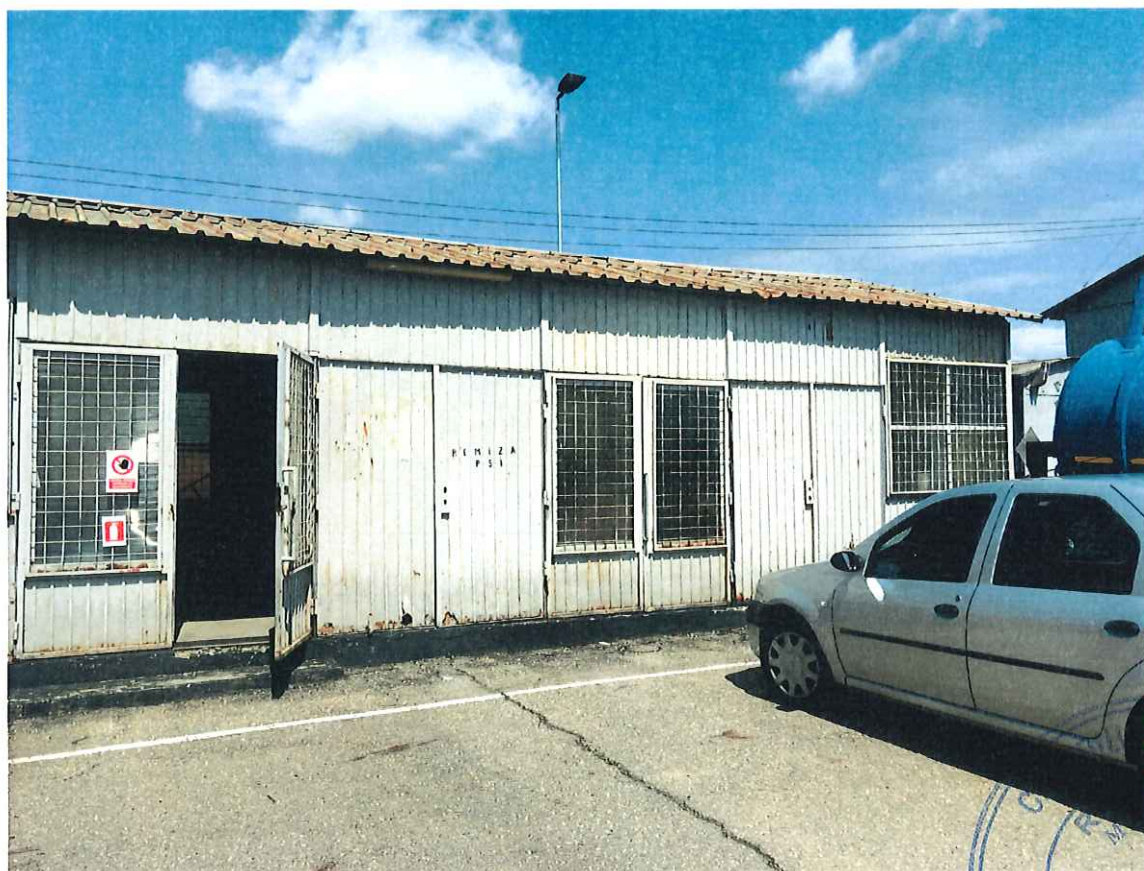
VEDERE LATERALA CLADIRE
