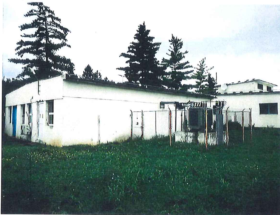
VEDERE EXTERIOARA CLADIRE - CORP DISTRIBUTOR E
