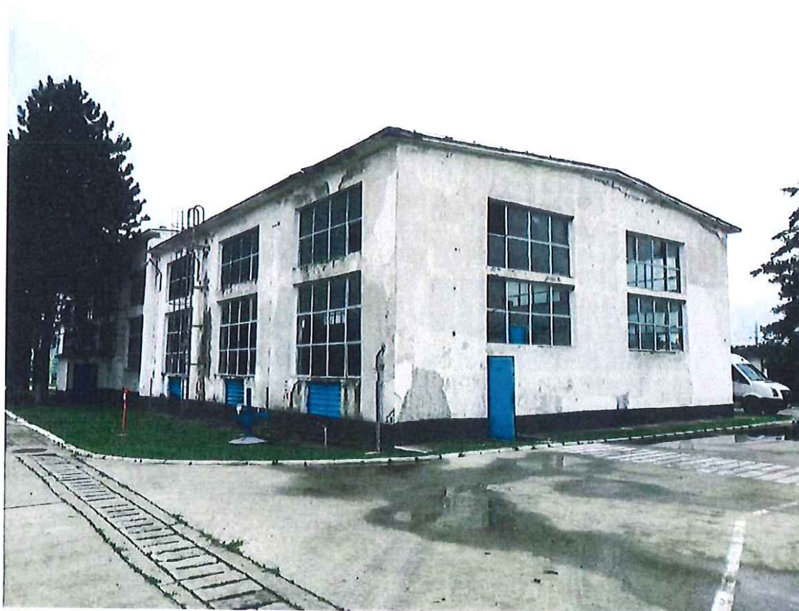
VEDERE VESTICA A CLADIRII
