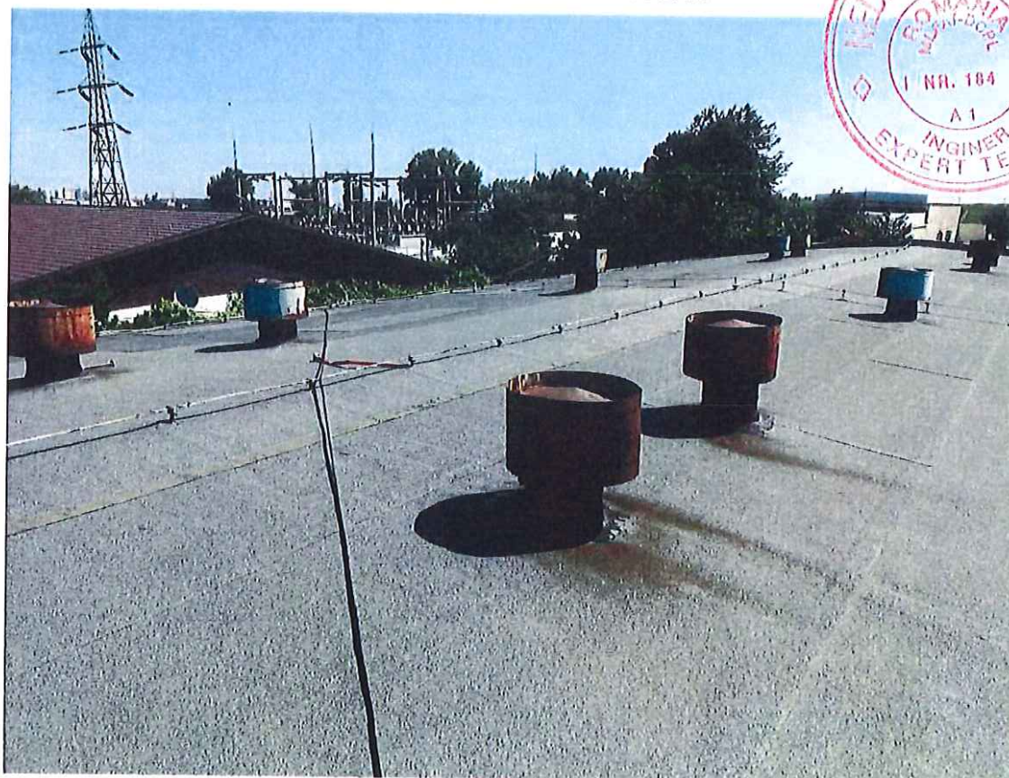
DETALIU HIDROIZOLATIE ACOPERIS.
