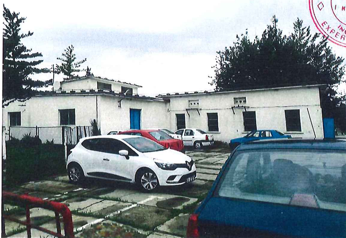
VEDERE EXTERIOARA CLADIRE - CORP DISTRIBUTOR D + ANEXA DEPOZITARE
