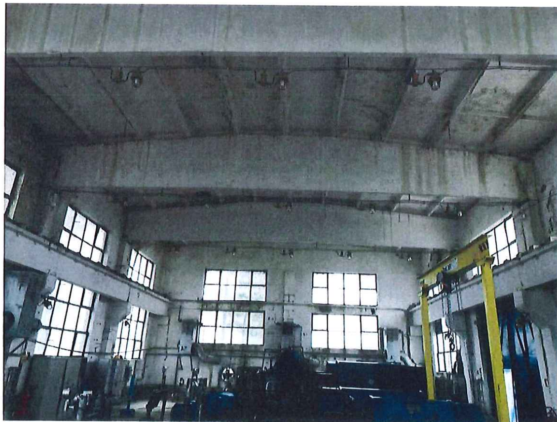
VEDERE INTERIOARA ZONA 1
