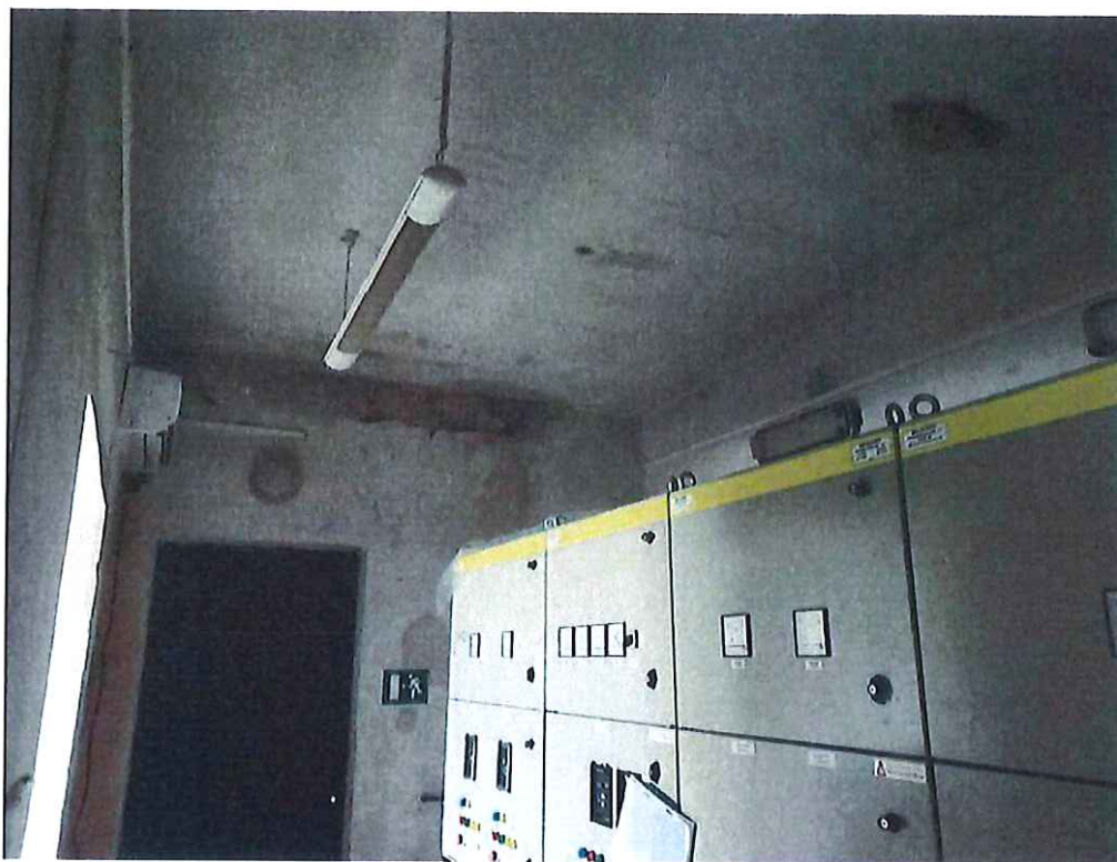
VEDERE INTERIOARA CLADIRE - CORP DISTRIBUTOR C – INFILTRATII PRIN PLANSEU.
