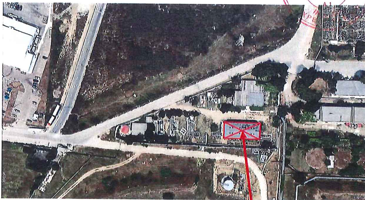
SALA DE POMPE
