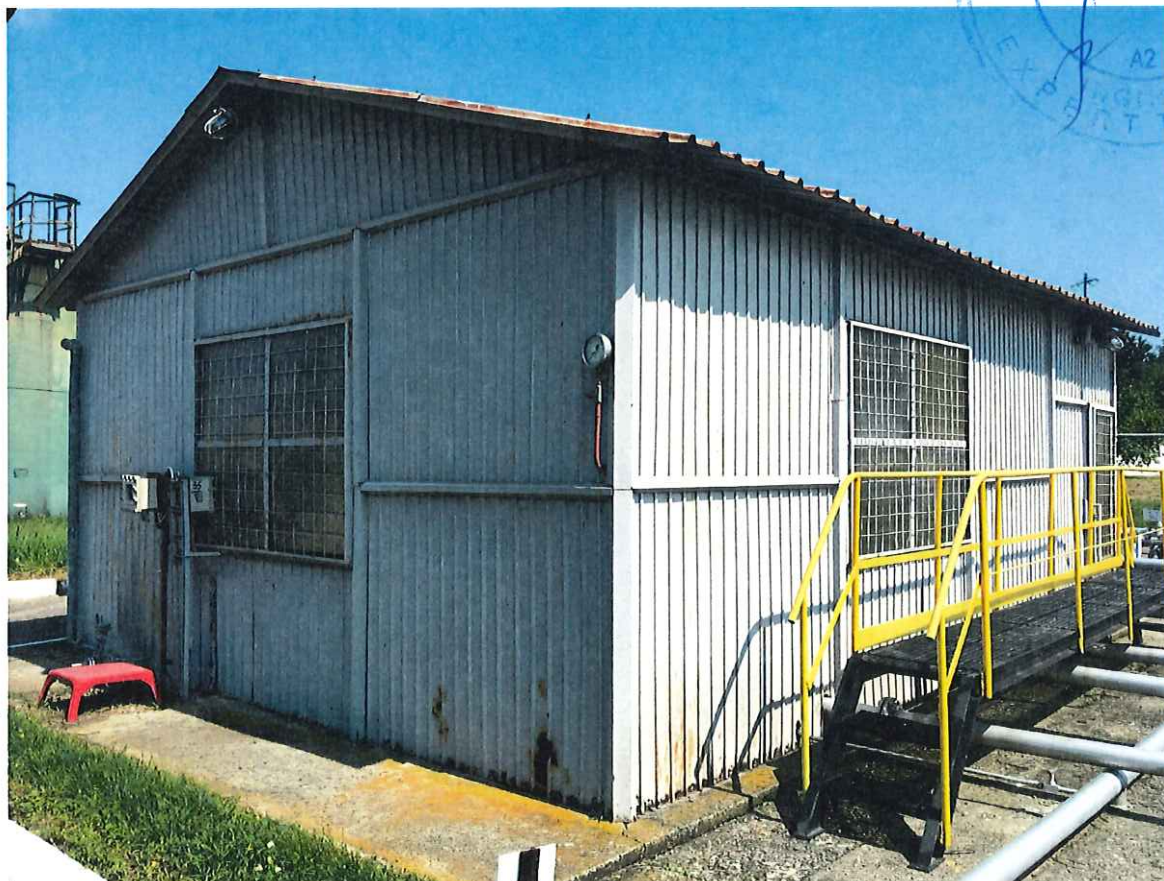
VEDERE LATERALA CLADIRE
