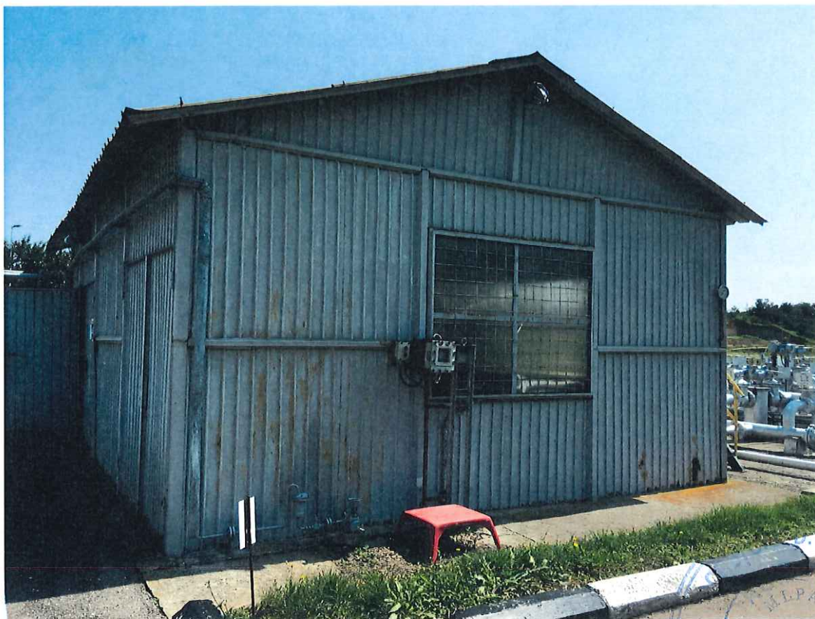
VEDERE LATERALA CLADIRE
