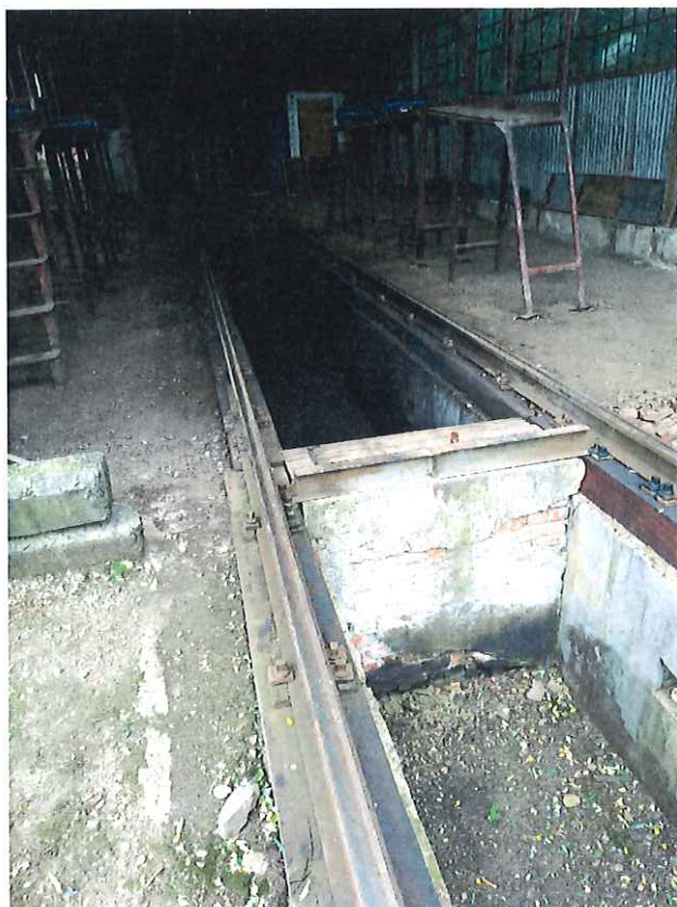
CANAL PENTRU ACCES SUB LOCOMOTIVA
