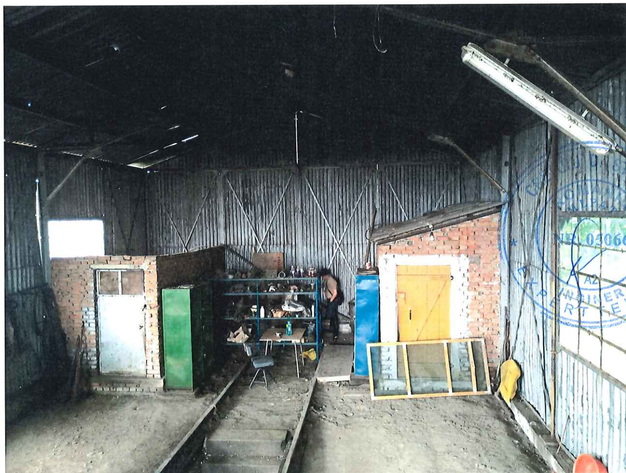
VEDERE ANSAMBLU CAMERE DIN ZIDARIE
