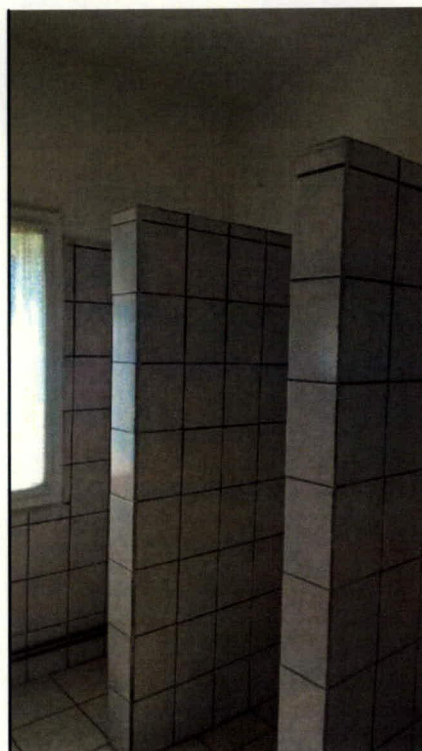
FOTO 12 INTERIOR 2 GRUP SANITAR
