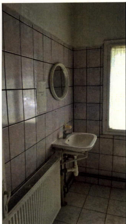
FOTO 11 INTERIOR 1 GRUP SANITAR
