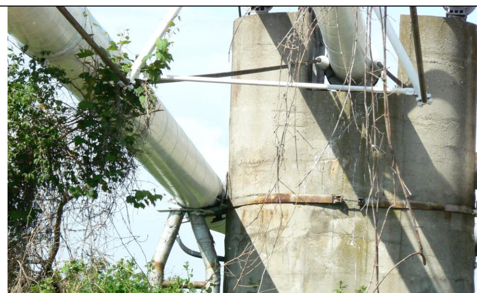
Fig. 10 (continuare) Detaliile reazemelor mobile amplasate pe malul stang
